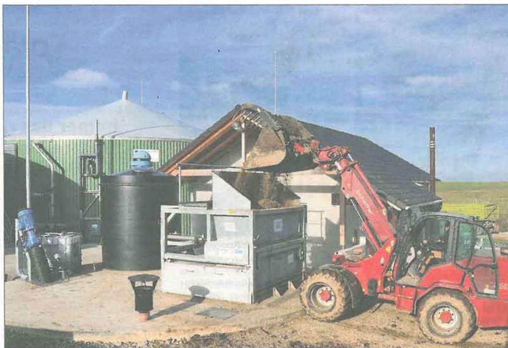
Fütterung über die Hydroschleuse. Der Radlader befüllt die obere Wiegeplattform.
