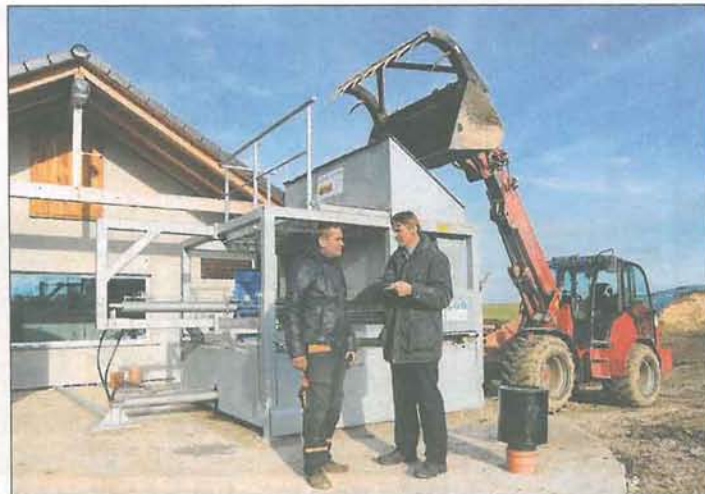
Firmenchef Peter Rohn (r.) wertet gemeinsam mit Betreiber Michael Ullrich die aktuellen Logfiles zu den Leistungsparametern der Biogasanlage aus. Im Hintergrund das mehrzeilige Großdisplay.
