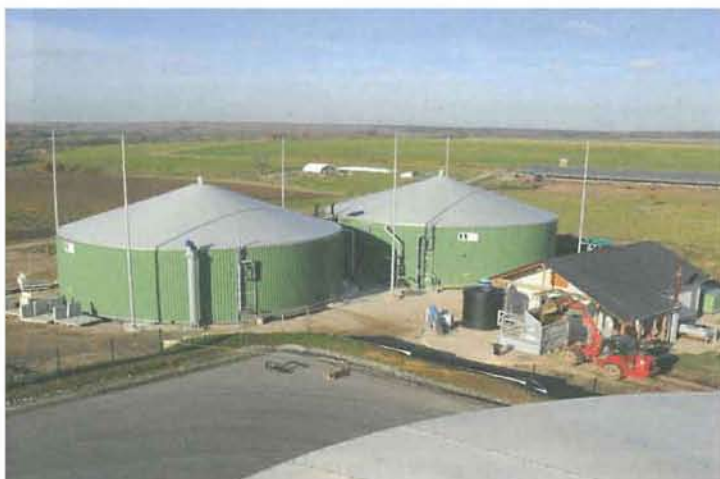
250-kW el -Biogasanlage auf dem Agrarbetrieb Ullrich in Aga bei Gera.
