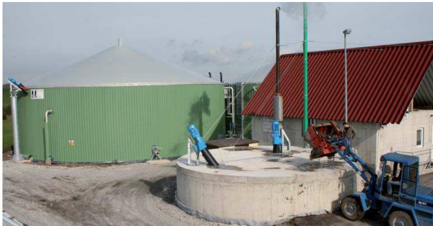
Der Hydrolysebehälter wird über eine Öffnung im Deckel beschickt und mit einem neuartigen Rührsystem wird das Substrat vermenget. Fotos: Rueß
