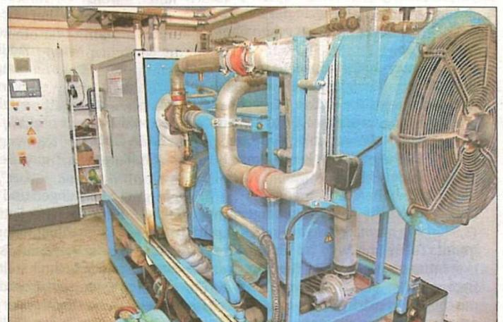
Die vom 100-kW-Zündstrahlmotor erzeugte Wärme wird per Wärmetauscher dem Warmwasserspeicher zugeführt.
